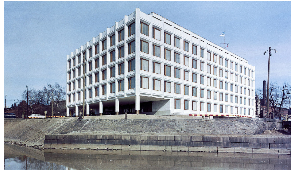
V94003:15421, Enso Gutzeit Oy:n pääkonttori 17.4.1962.
